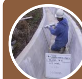
シーリング材充填
