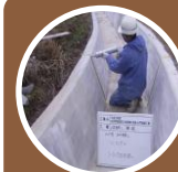
シーリング材充填
